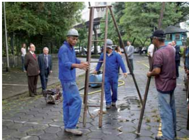
Edif inicia os trabalhos da obra de construção da Escola
